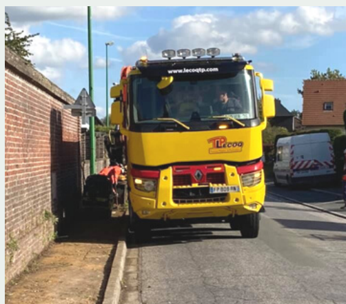
Réfection du trottoir du centre socio-culturel.
