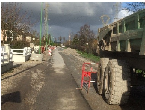
TRAVAUX ROUTE DU TRAIT
