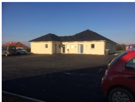
PARKING DE LA MAISON MEDICALE
